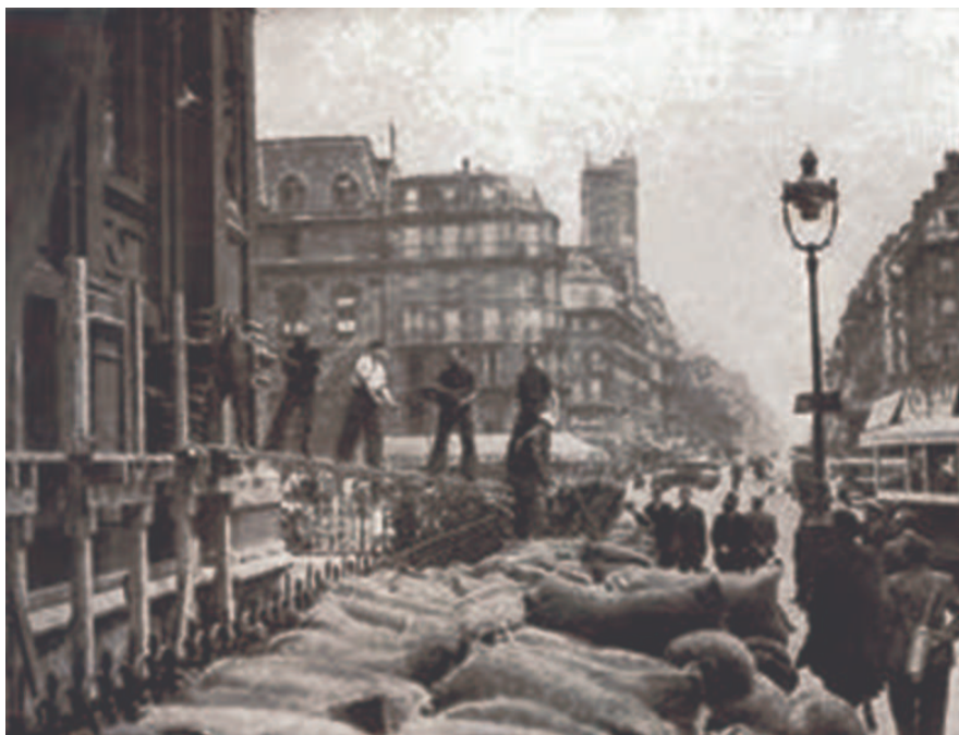
Protezione dell'Hôtel de Ville con sacchi di sabbia
