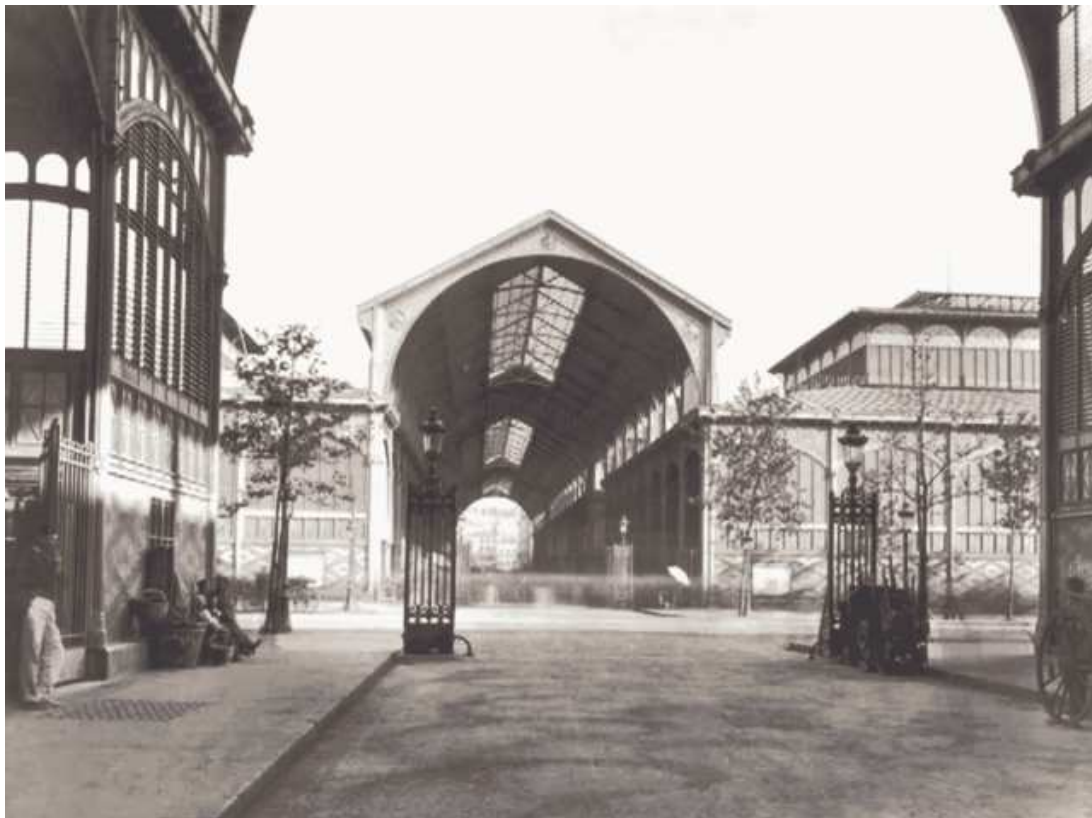
Les Halles Centrales
