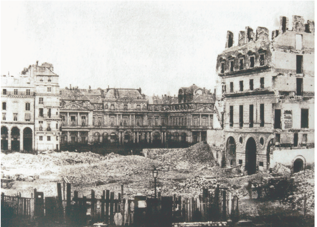
Place du Carrousel (1865). Au fond on aperçoit le palais des Tuileries
